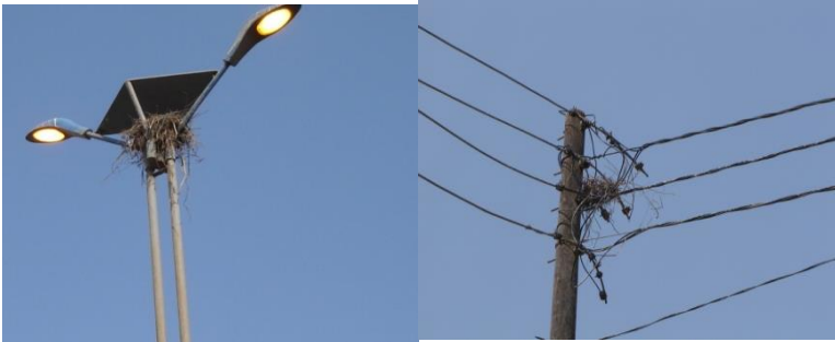
شكل (٦) يوضح اعشاش الغربان على برج الإضاءة في شارع الكورنيش / الحديدة.
